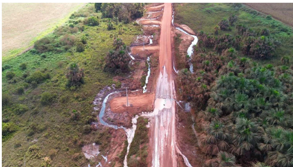
FOTO 23 – VISTA GERAL DA ÁREA DEGRADADA
