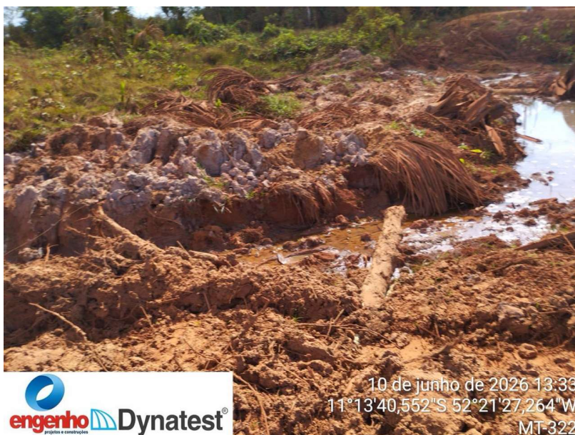
FOTO 13 – ÁREA DE NASCENTE ATERRADA EM DECORRÊNCIA DA MOVIMENTAÇÃO DE SOLO
