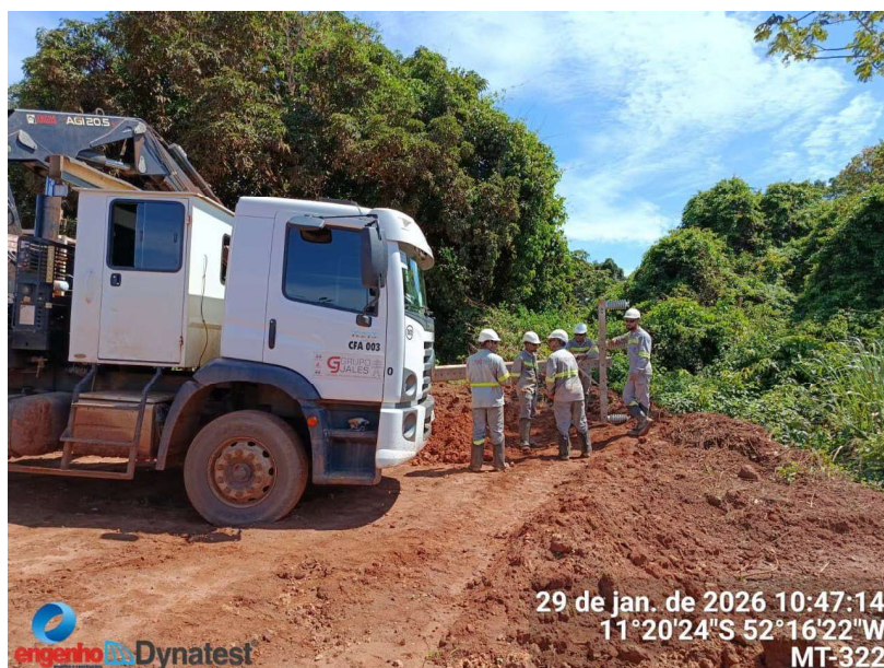
FOTO 2 – IMPLANTAÇÃO DE POSTES DE ENERGIA NA RODOVIA MT-322
