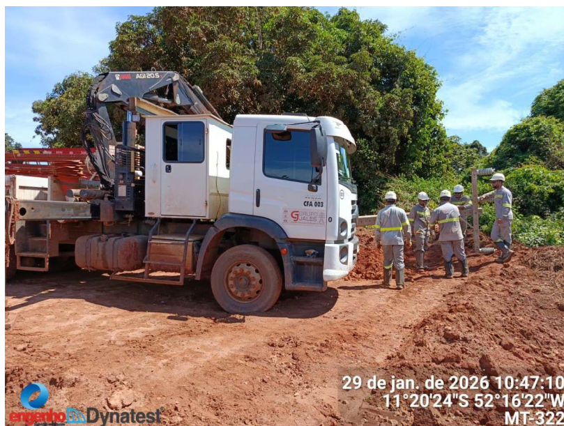
FOTO 1 – IMPLANTAÇÃO DE POSTES DE ENERGIA NA RODOVIA MT-322
