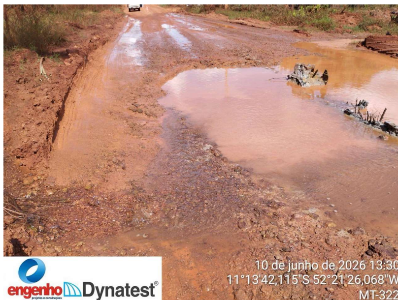
FOTO 19 – ÁREA ONDE FOI CONSTATADO O ATERRAMENTO DA DRENAGEM NATURAL, RESULTANDO NA OBSTRUÇÃO DO FLUXO HÍDRICO E NO ESCOAMENTO DA ÁGUA SOBRE A PISTA
