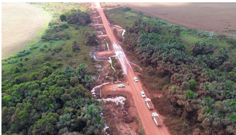
FOTO 25 – VISTA GERAL DA ÁREA DEGRADADA
