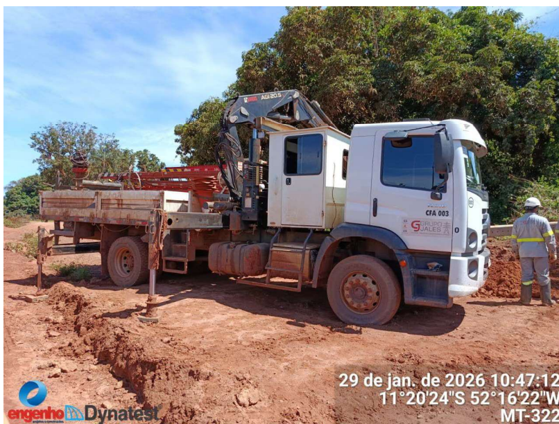
FOTO 3 – IMPLANTAÇÃO DE POSTES DE ENERGIA NA RODOVIA MT-322
