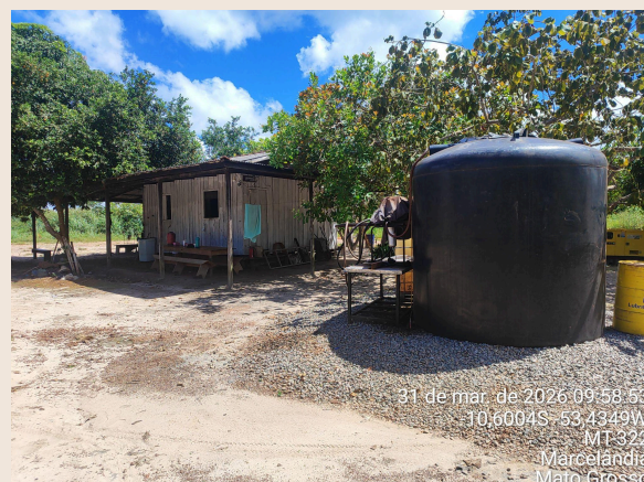
Foto 04 - 31/03/2026 - Local do refeitório do canteiro de obras.
